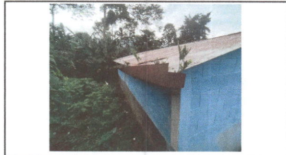
Foto 4: Sustitución de canal de metal
