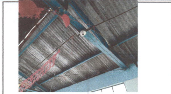
Foto 2: Mantenimiento a estructura de soporte de metal
